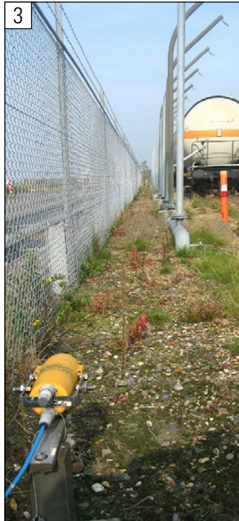
Detector de gas al punto de carga y de descarga de vagones cisternas
