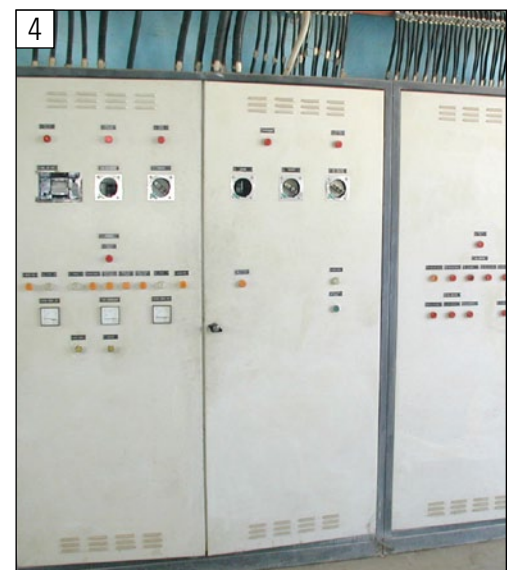
Panel de alimentación para zona no peligrosa
