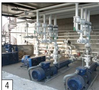
4 Installation de pompe GPL
