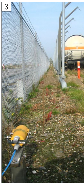
Détecteur de gaz au point de chargement et de déchargement pour wagons-citernes
